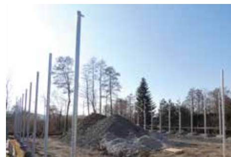
Výstavba hřiště pro plážový volejbal.
