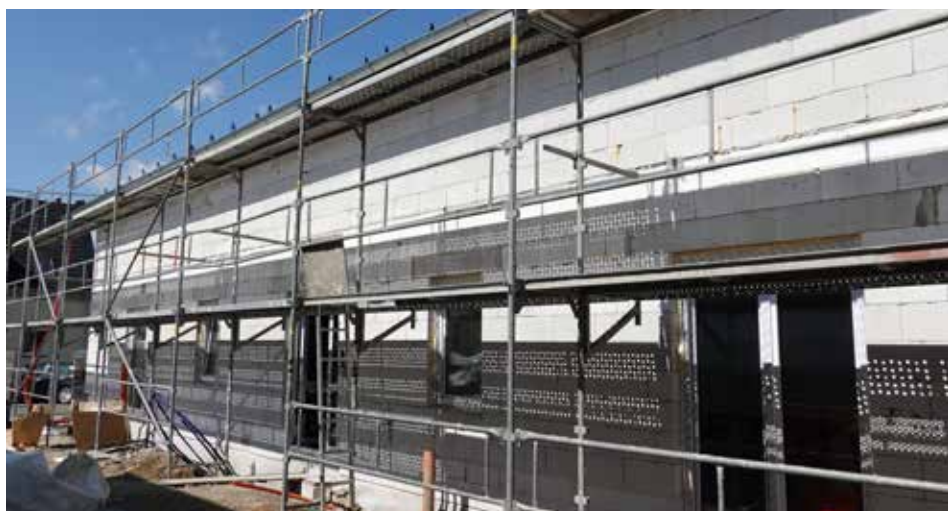
Pohled na jižní stranu budovy.
