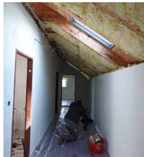
Stavební práce na chodbě v 1. patře.
